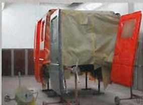
Vor Ort werden die Aufbauten auch lackiert.
